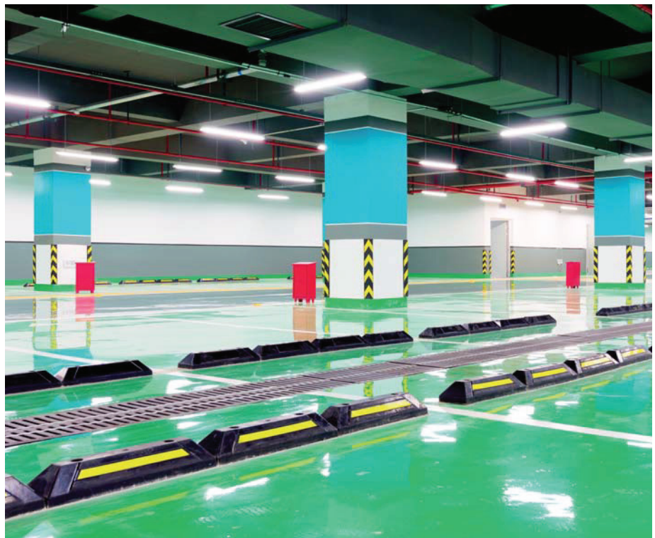
Освещение крытой парковки.
