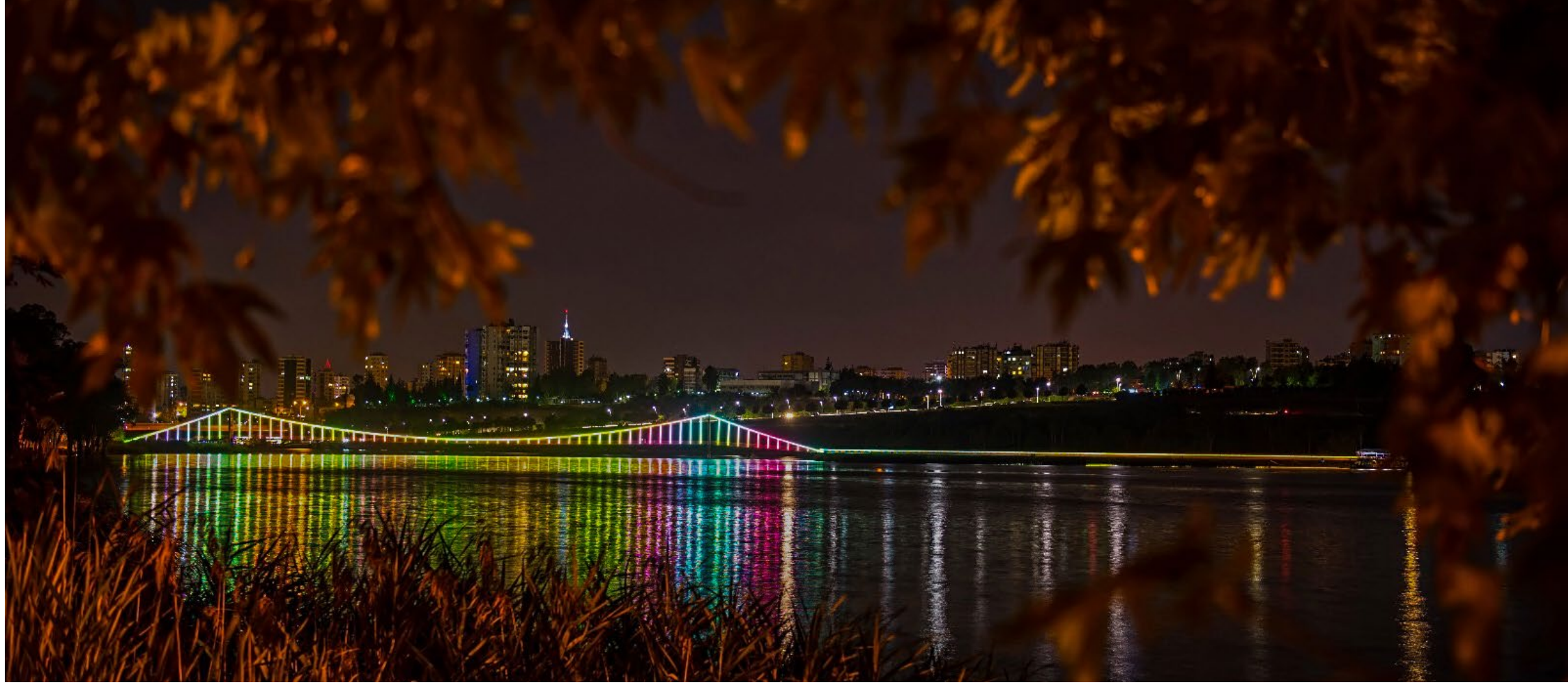
Dostluk ve Gençlik Bridge - Adana
